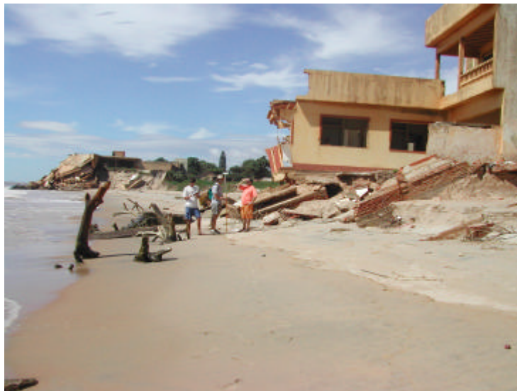
Fig. 6 – Fotografia indicativa de outras duas construções seriamente danificadas pela erosão próximas do pontal de Atafona.
